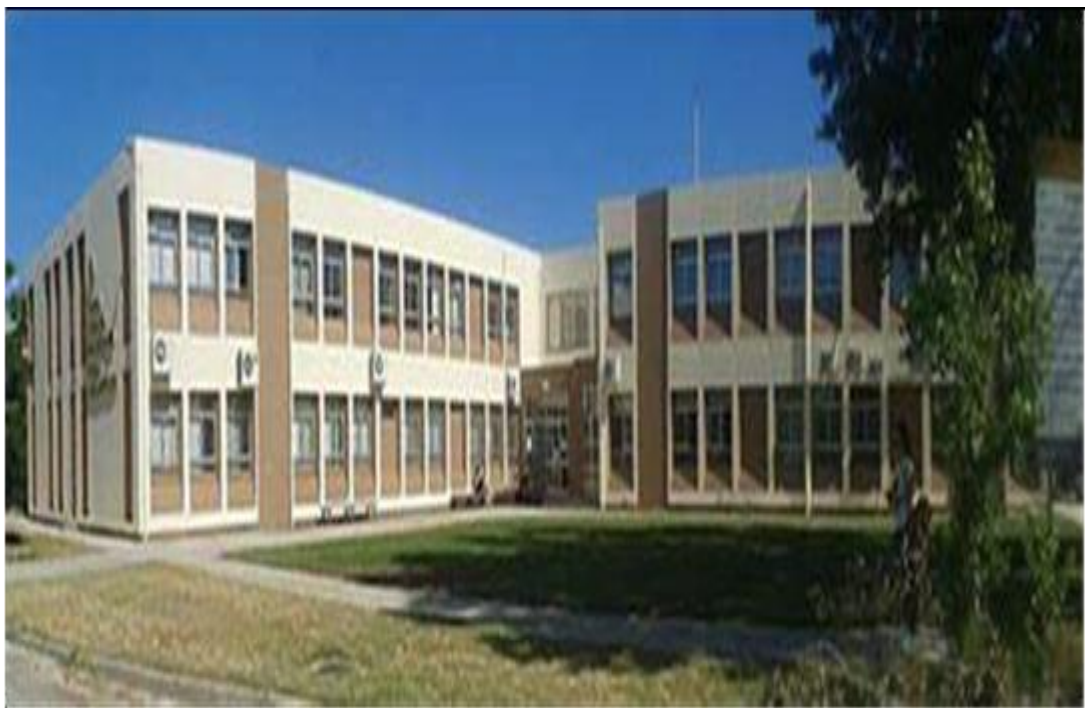
Όψη του κτιρίου του Τμήματος Νοσηλευτικής
